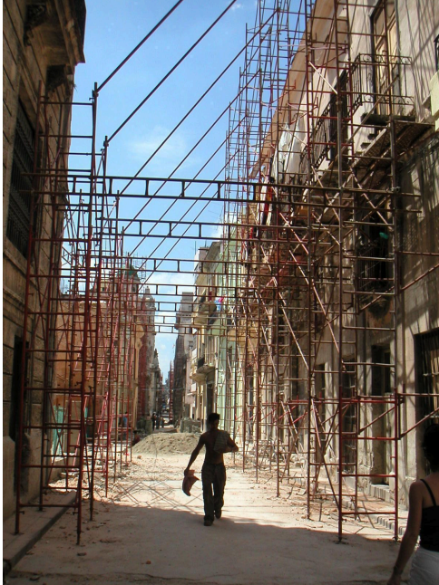
Figura 45 - Restauración de edificios en la antigua Habana
