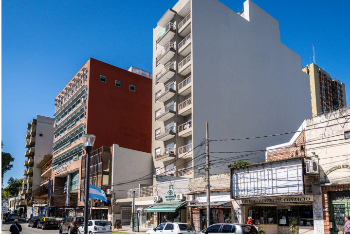
Figura 28 - El edificio fue desarrollado bajo la nueva normativa del CODC
